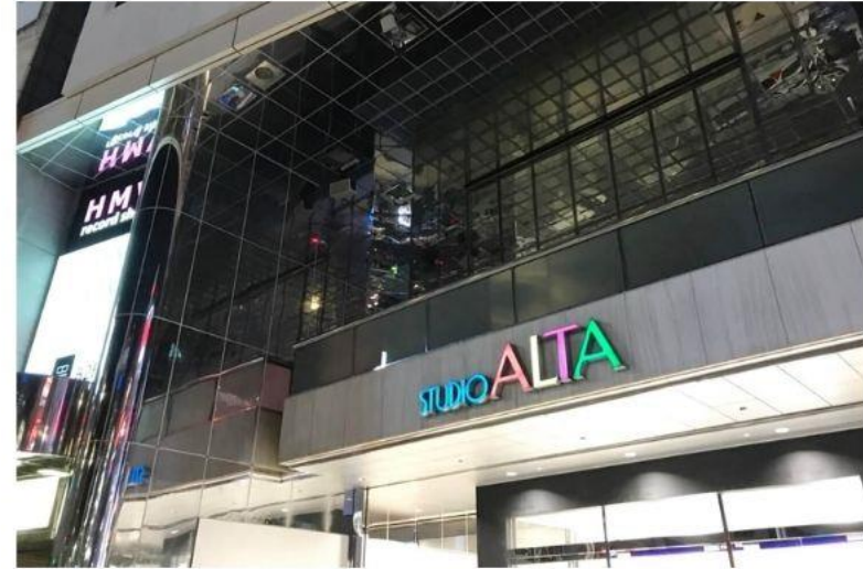
新宿アルタ モニター下の防水工事
