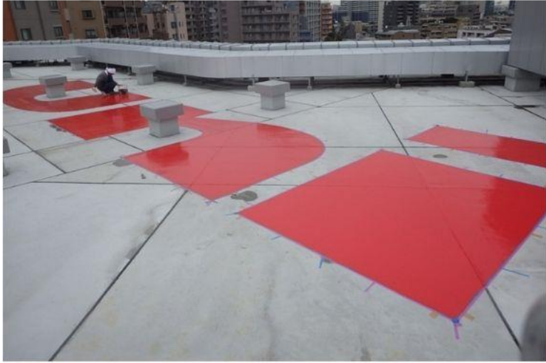
三菱鉛筆本社ビル 屋上のUNI塗装
